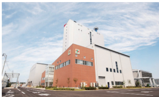
株式会社レノバ提供:秋田バイオマス発電所
